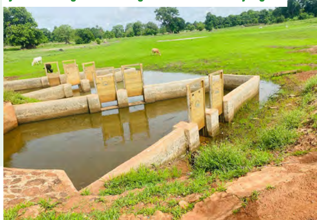
Système d'irrigation aménagé dans la Vallée de Djiragone
