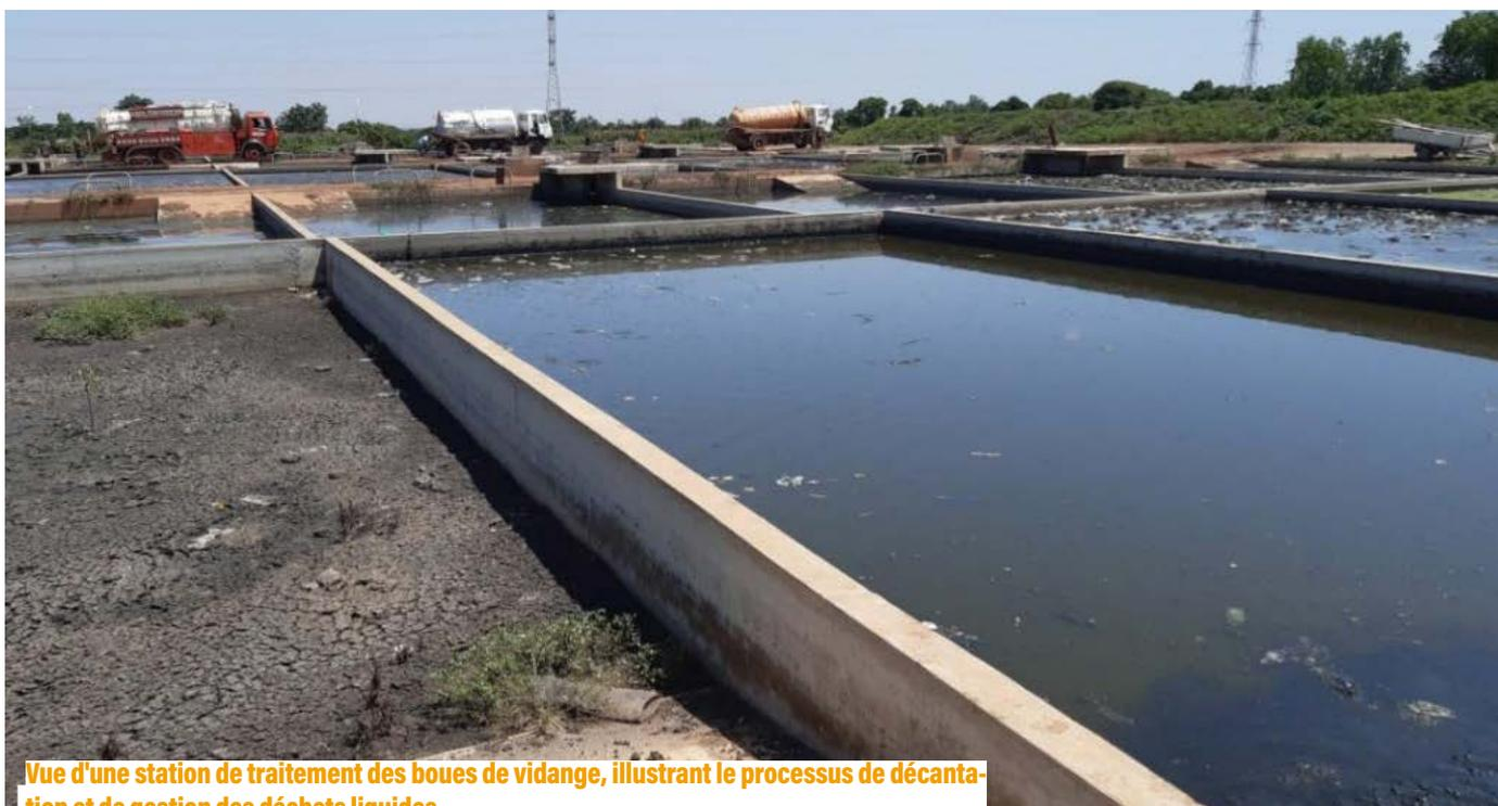
**Vue d'une station de traitement des boues de vidange, illustrant le processus de décantation et de gestion des déchets liquides**
