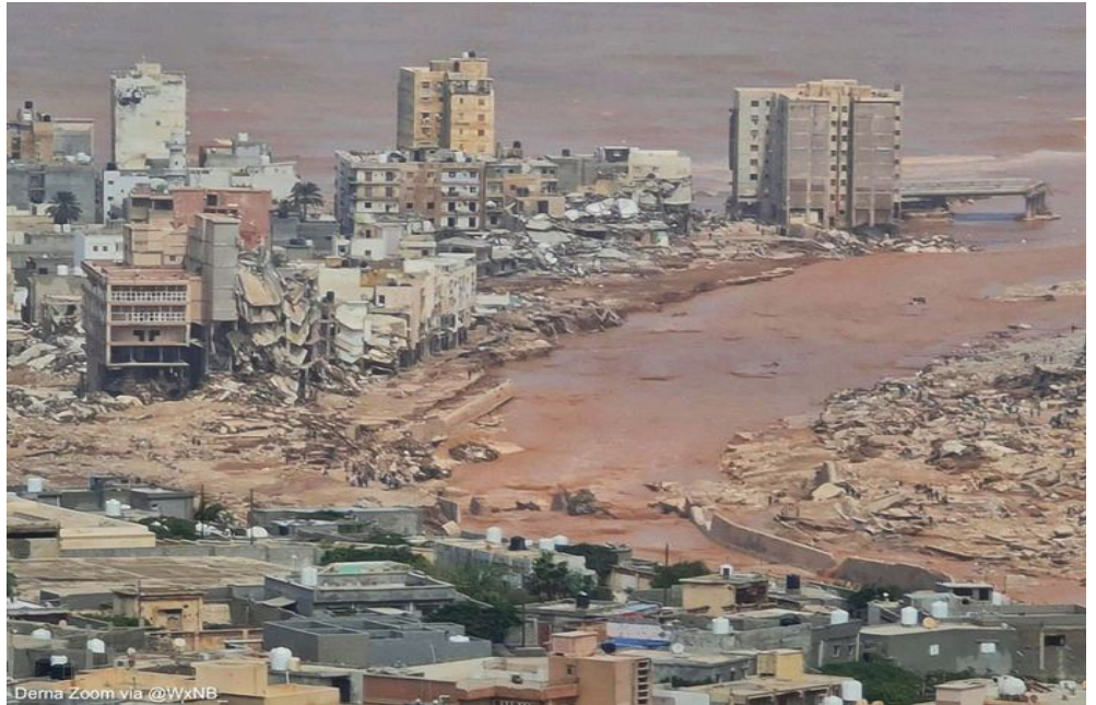
Dégâts causés par la tempête Daniel en Libye
