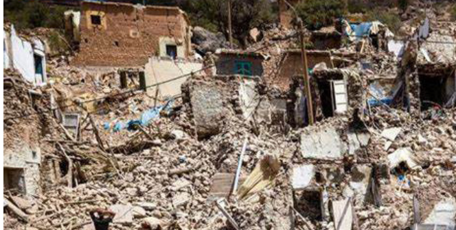
Dégâts causés par le séisme survenu le 09 septembre 2023 au Maroc
