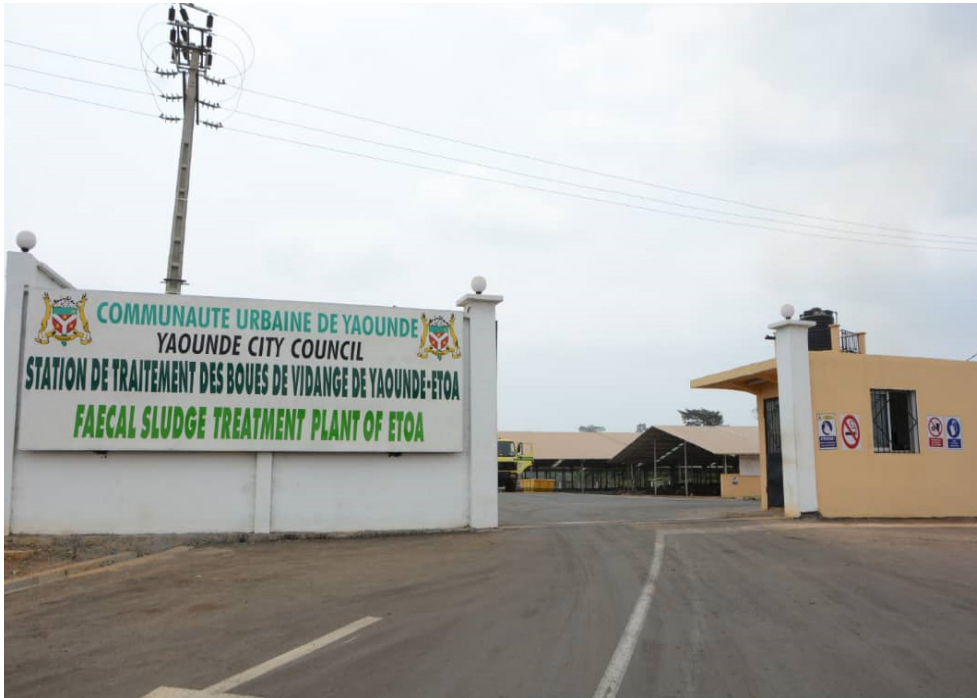
Station de traitement des boues de vidange © Communauté Urbaine de Yaoundé
