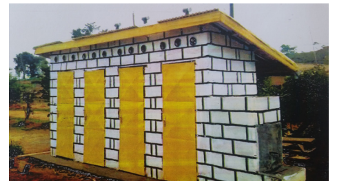
Latrines publiques. © Celcom
