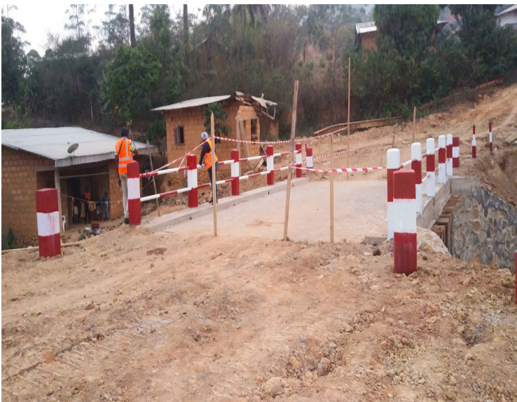
Un chantier de pont à Fokoué. Celcom
